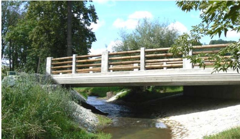
Kurz nach Fertigstellung! - Bitte Schlankheit beachten! – 12,6m Stützweite im Bogen bei 40cm Platte! (L/H ~ 31,5!)
