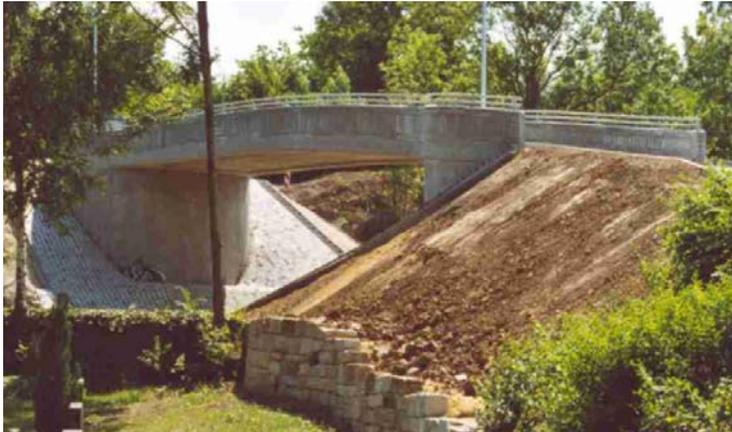
Brücke „Am Gipsbruch“ (Ausführungsplanung / Entwurfsplanung) Vorgespannter Trogquerschnitt mit runden Widerlagern
